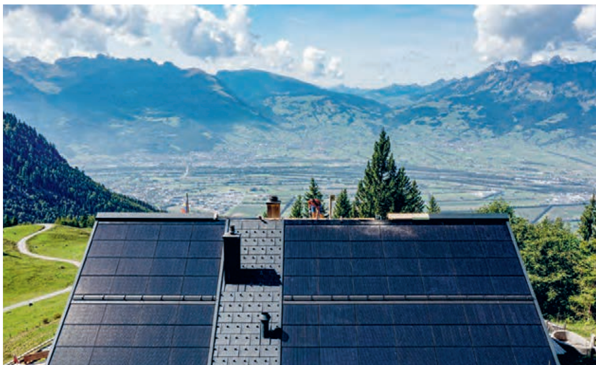
Die neu erstellte Photovoltaikanlage auf der Gafadurahütte hat eine installierte Leistung von fast 30kW.
