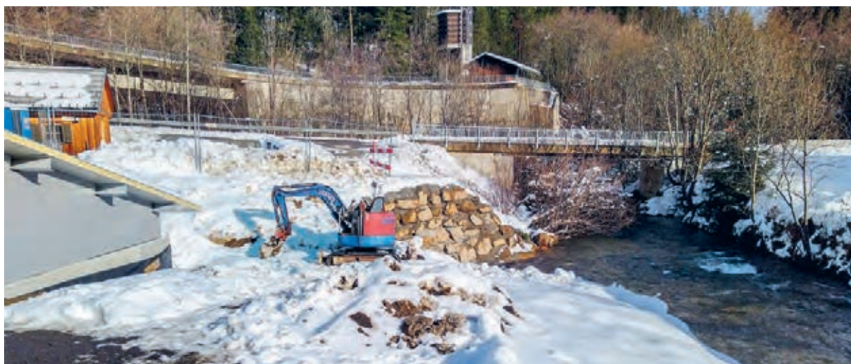
Bauarbeiten am Packerbach
